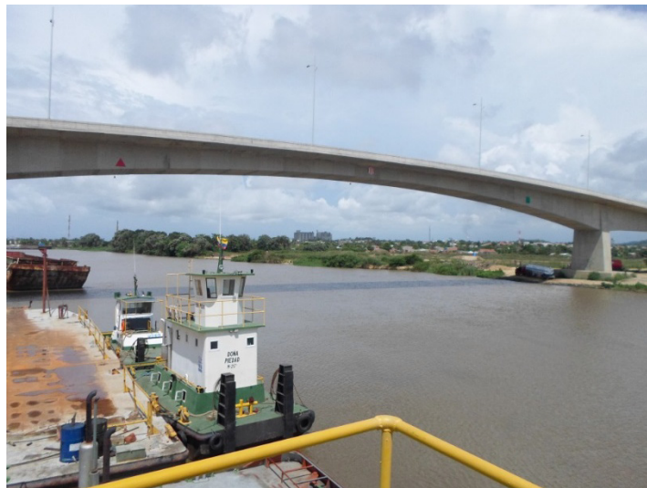
Puente sobre el Canal del Dique, Pasacaballos-Barú
